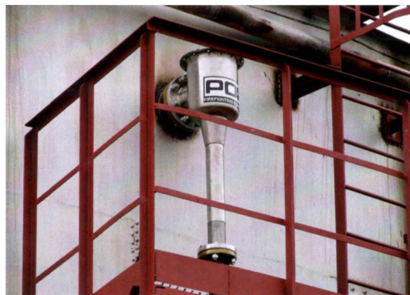
СХЕМА КРЕПЛЕНИЯ ПЕНОКАМЕРЫ ТИПА TPS К ФЛАНЦУ РЕЗЕРВУАРА ДЛЯ ПЕНОГЕНЕРАТОРА ГПС-2000.
